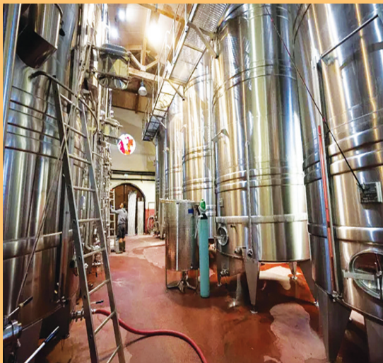
Cuve de stockage inox
