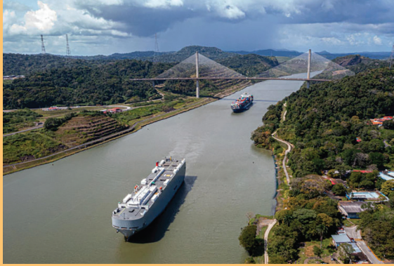
Vue du canal
